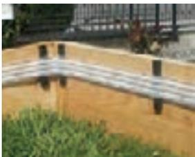
Cinta instalada sobre madera con aisladores AC-2 cada 30 cm. amarrados con tornillos de 3 X 10 mm.
